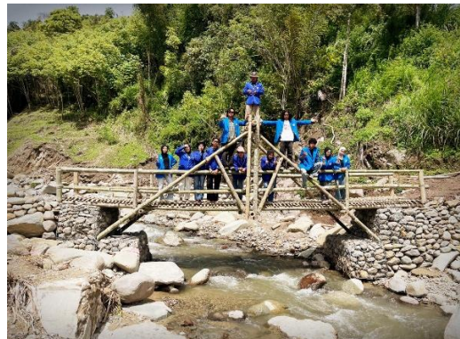
Gambar 14. Uji beban dan inspeksi akhir.
