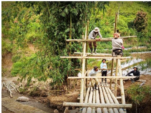
Gambar 10. Pemasangan rangka penguat.
